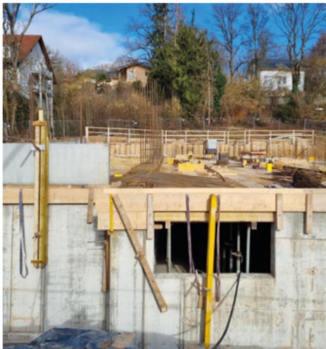
Nach einigen Verzögerungen, die durch notwendige Gründungs- und Hangsicherungsmaßnahmen sowie die Entsorgung des von Natur aus arsenhaltigen Aushubmaterials gekennzeichnet waren, konnte nach einer dreiwöchigen Winterpause mit der Herstellung der Fundamente und der Bodenplatte fortgefahren werden.
